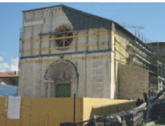
Particolare di fasciatura in poliestere
